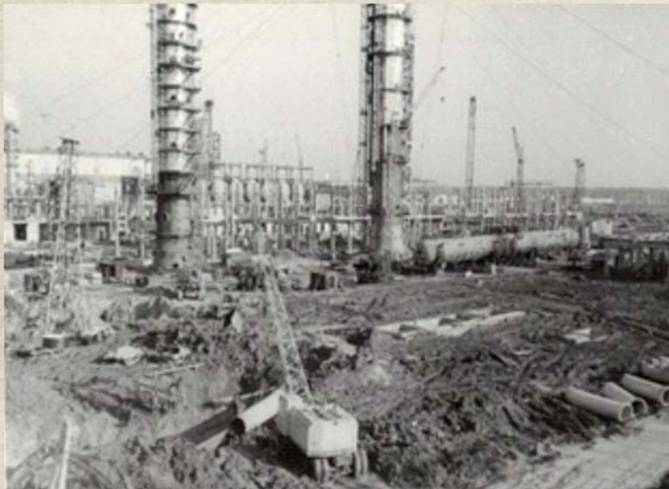
Строительство Тобольского нефтехимического комбината, 1974г.
