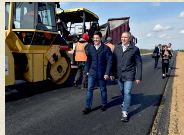
Осмотр строительства дороги Надым-Салехард, 2018г.
