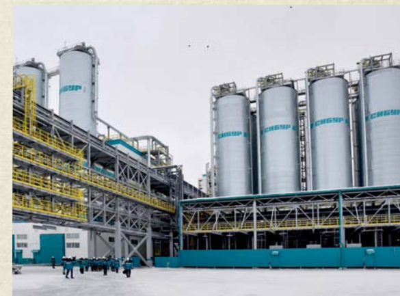
Строительство нефтехимического комплекса «ЗапСибНефтихим» в г. Тобольске, 2019г.
